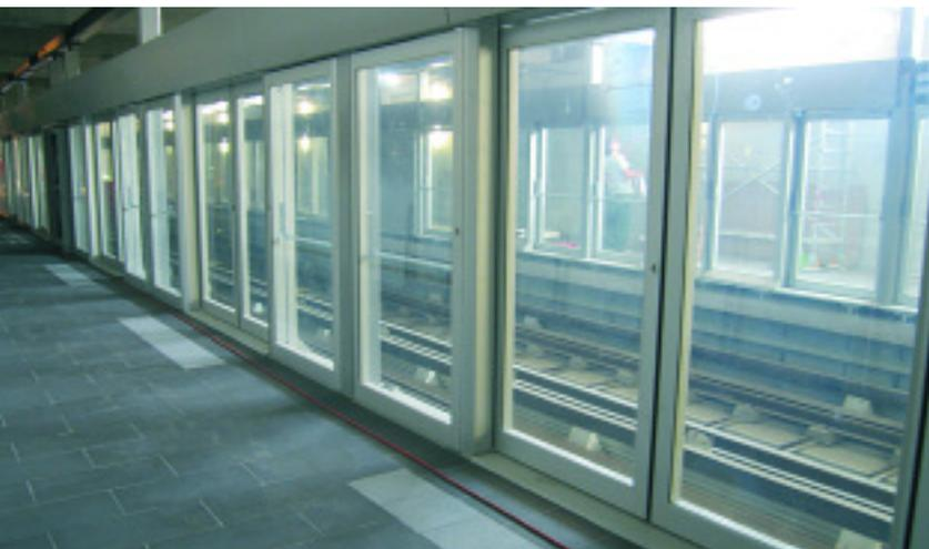
portes de secours permettent de quitter la voie si, par exemple, le train n'est pas correctement arrêté en station.
