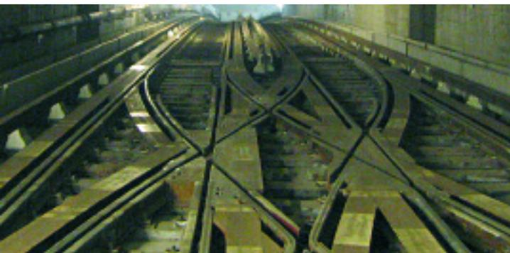
La voie du m2, c'est avant tout quatre profilés métalliques, deux sur lesquels roulent les roues qui portent le train - comparables à celles d'un camion - et deux sur lesquels roulent des roues à axe vertical pour guider les trains. Ces profilés se nomment pistes de roulement et barres de guidage.
